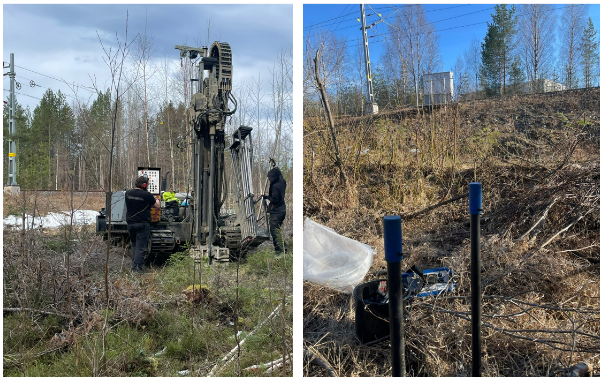
Figur 3. Borrningsarbeten på norra sidan om järnvägen och fastigheten Industrin 6.
