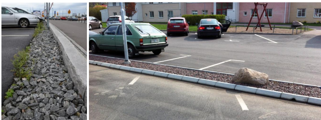
Figur 19. Till vänster: Makadamdike på parkeringsplats. Till höger: Diket avleder dagvatten från en parkeringsyta. Dagvattnet rinner in i diket via hål i kantstenen. Foto: WRS
