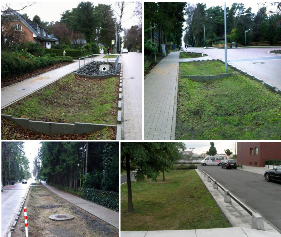
Figur 17. Exempel på hur svackdiken kan utformas. De två översta och det nedre vänstra diket innehåller dämmande sektioner vilket förstärker den flödesutjämnande kapaciteten. Svackdiket nere till höger har kombinerats med en vägslänt som fungerar som översilningsyta. Vattnet rinner på bred front från vägytan till översilningsytan och vidare till svackdiket där träd även finns planterade. Foto: WRS
