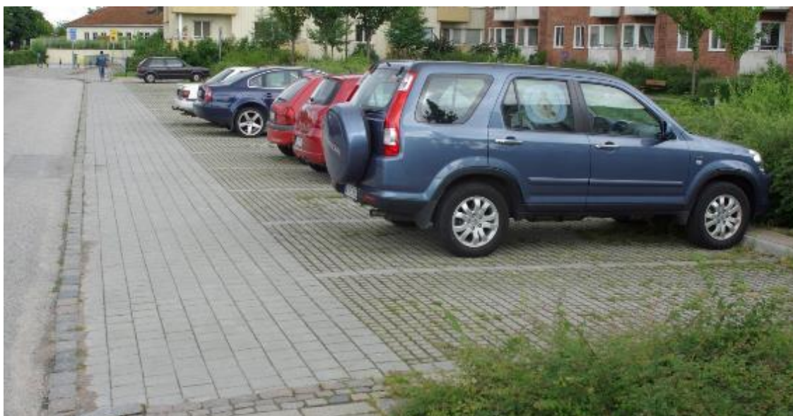
Figur 27. Exempel på parkering med genomsläpplig beläggning. Foto WRS.
