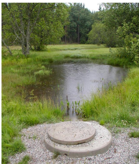
Figur 21. Till vänster: Dammutlopp via en munkbrunn. Vattennivån kan regleras och vatten ledas ut under ytan så att flytande föroreningar kan hållas kvar i dammen. Till höger: En långsmal dagvattendamm förlänger uppehållstiden samt underlättar vid underhåll och rensning. Foto: WRS
